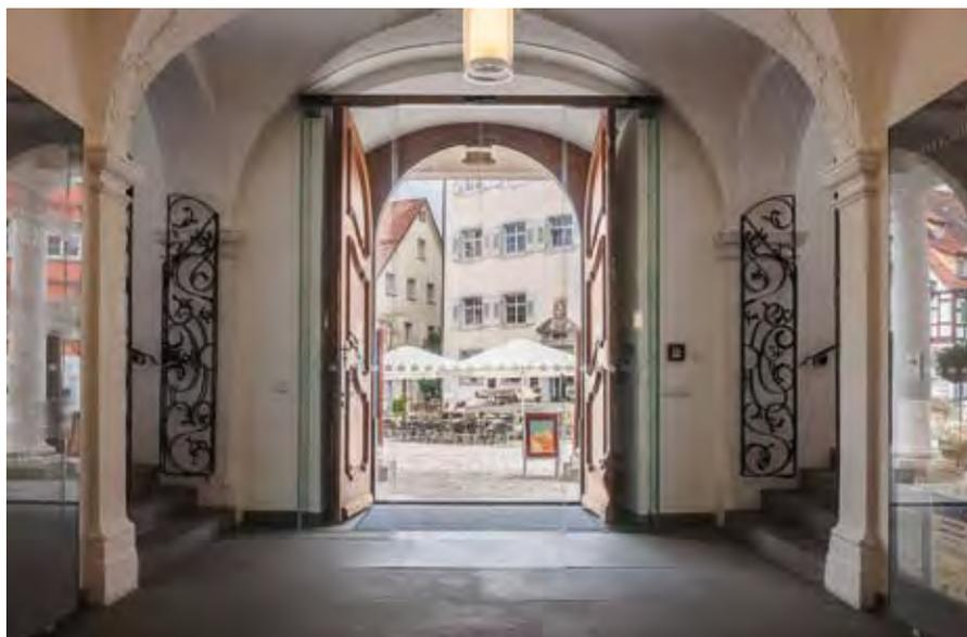
**Abb. 121 und 122** Die schwere bauzeitliche Außentür steht zu Öffnungszeiten offen, den Wetterabschluss bildet dann die selbstöffnende Glastür im Gebäudeinneren.
