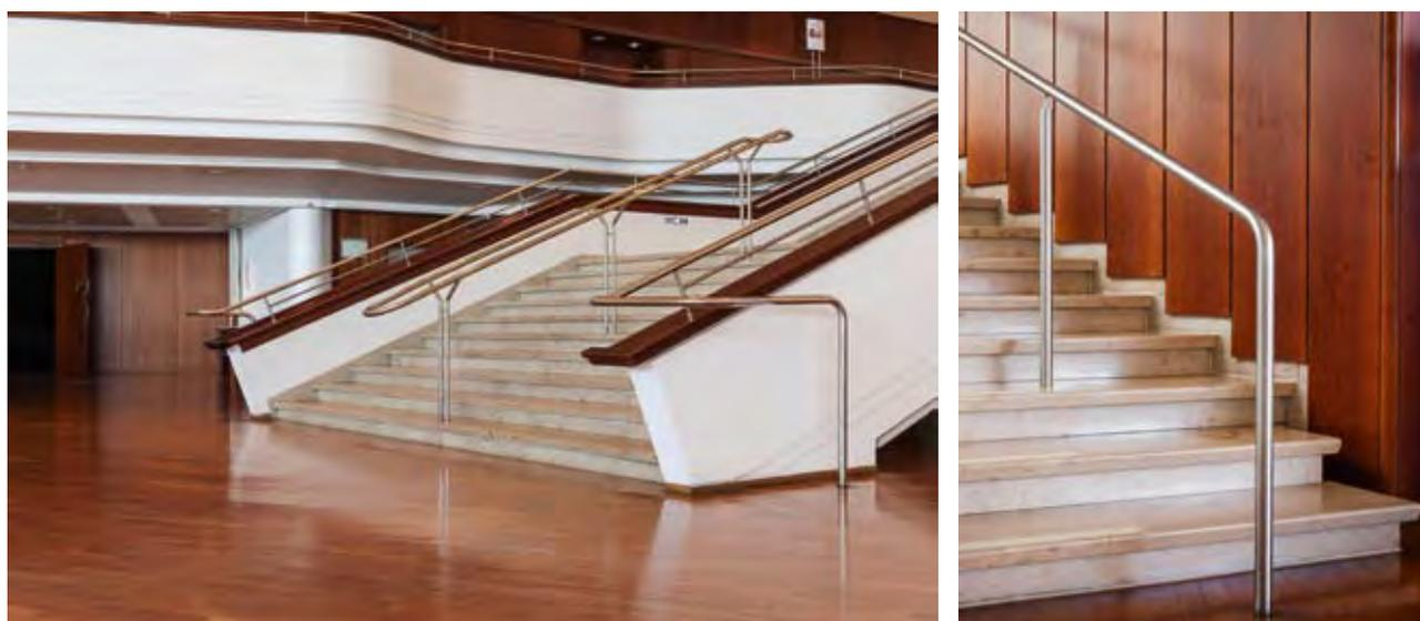
**Abb. 148 und 149** Treppenanlagen mit barrierefreien Handläufen und rutschfesten Stufenkanten. Der nach DIN 18040-1, Ziffer 4.3.6.2 zulässigen Unterschneidungen der Treppenstufen von maximal 2 cm wurde bei diesem Bauvorhaben noch keine hinreichende Aufmerksamkeit geschenkt. Achtung – Unterschneidungen sind Stolperfallen.
