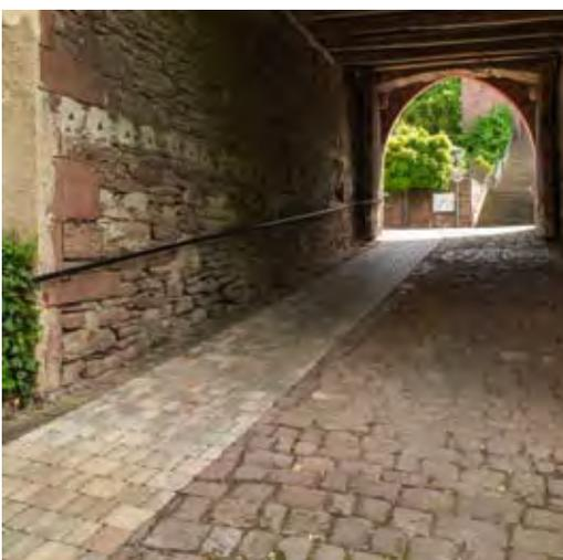
**Abb. 23** Der Ersatz von schwer befahr- oder begehbareren Pflastersteinen und das Anlegen eines separaten Geh-/Fahrstreifens wie in Tiefenbronn-Mühlhausen (Zugang zum Pfarramt) ist eine denkmalverträgliche Lösung, die sich in besonderer Weise bei Flächen eignet, die ohne ornamentale Gestaltung angelegt sind.
