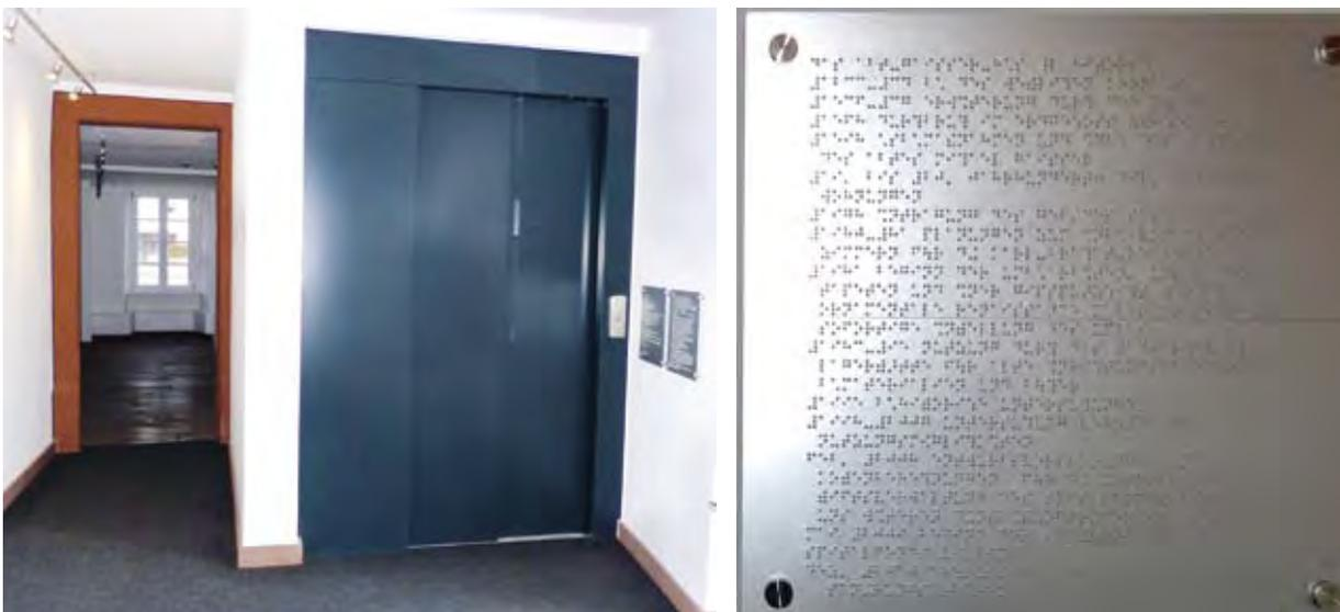
**Abb. 107** Eingangsbereich mit Aufzug. Die barrierefreie Erschließung der einzelnen Geschosse ist gegeben, jedoch ist der Aufzugtaster (außen) für Menschen im Rollstuhl schwer oder gar nicht erreichbar. Eine seitliche Anbringung 50 cm von der Wand entfernt wäre eine barrierefreie Konzeption.
